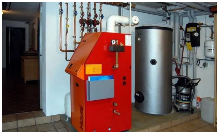
Рисунок 3 - Котел на жидком топливе
